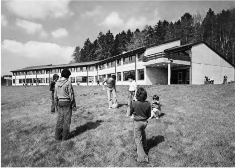
Carte postale imprimée à l'occasion de l'inauguration du « nouvel Arzillier » en 1977. © Établissement primaire de La Sallaz, Lausanne.
