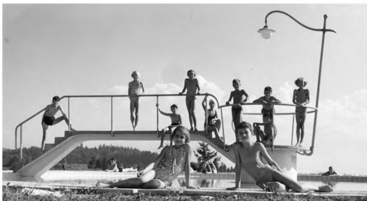
Piscine de l'Arzillier. Vers 1955.
